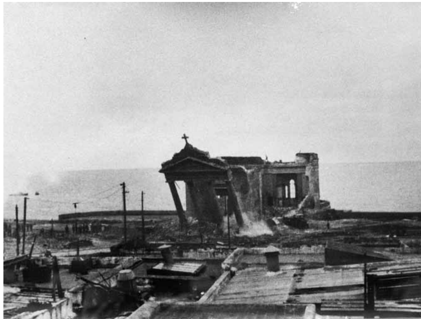
Demolición del Templo Inglés durante las obras de construcción de la Rambla Sur, 25 de octubre de 1934. Fotografía: Sra. Martorell de De Mula.
